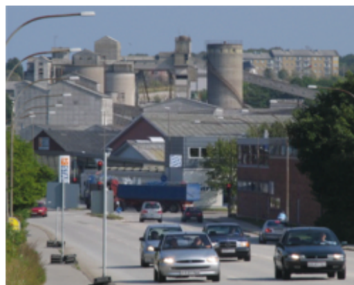
Området har en central beliggenhed ved Østre Allé og Sønderbro og husede tidligere Dansk Eternitfabrik.
